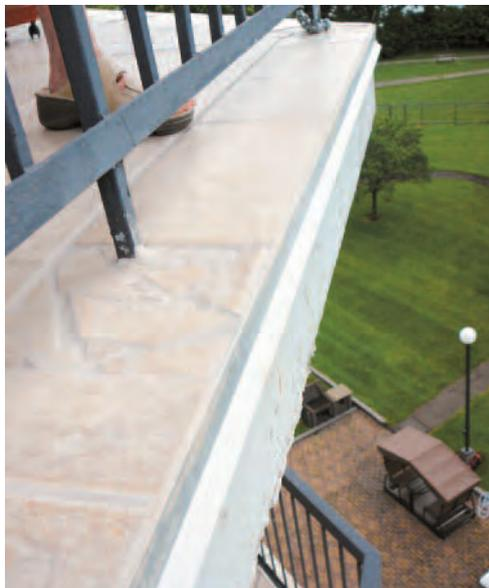
Combinant plusieurs fonctions, cette moulure est la solution à maints problèmes qui surviennent par l'égouttement des eaux pluviales sur les dalles de balcon recouvertes de tuiles de porcelaine. Ce produit unique, **MAG 7<sup>MC</sup>**, fait dévier les eaux à une distance suffisante pour assurer l'intégrité du béton, éviter le décollement des tuiles et empêcher la formation de stalagmites sur les faces extérieures de la dalle de béton.
