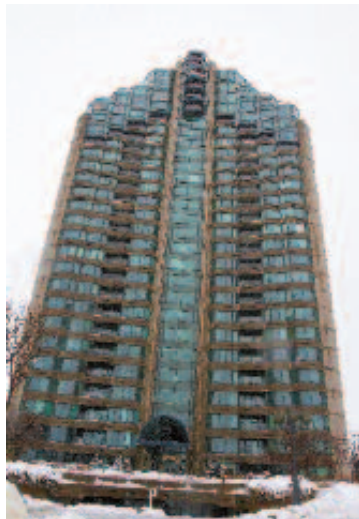
AutoGestion Verrières I à V met actuellement à jour son système d'alarme incendie. Chaque copropriétaire pourra ainsi économiser, annuellement, entre 50 et 75 dollars en primes d'assurance.
